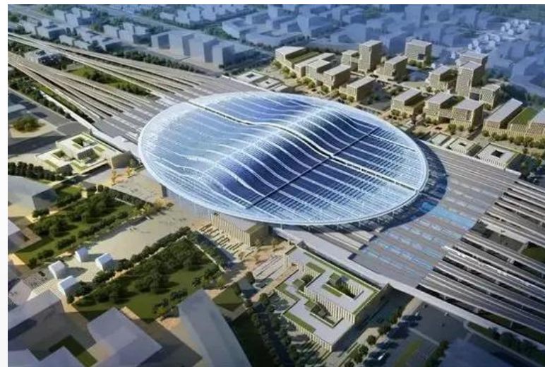
亚洲最大高铁站:光伏组件4.2万平方米,总装机容量6兆瓦,年均发电量580万千瓦时
