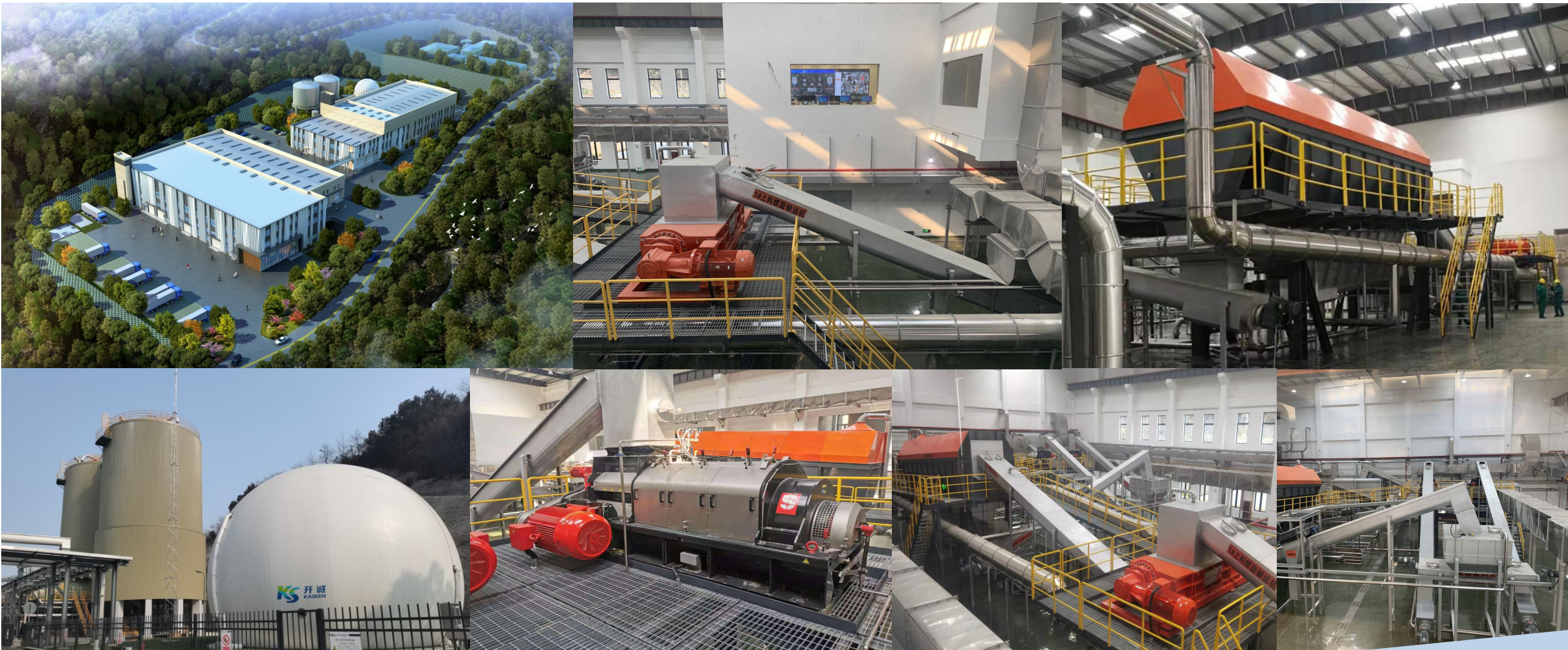
杭州天子岭厨余垃圾干法厌氧工艺装备系统供货服务
