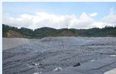
填埋气体收集系统
