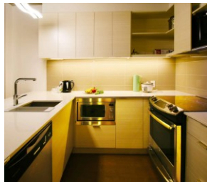
全电化厨房（住宅公寓）
