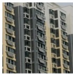
住宅楼立面太阳能热水
