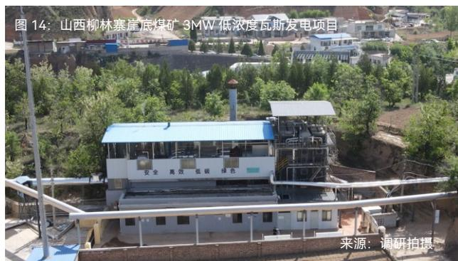
案例 2 分析关注的是位于山西省吕梁市的柳林寨崖底煤矿 3MW 低浓度瓦斯发电项目，主要处理 9% 以下的低浓度瓦斯。该项目是旨在充分利用煤矿瓦斯资源、减少甲烷排放、提高能源利用效率的创新性项目。
