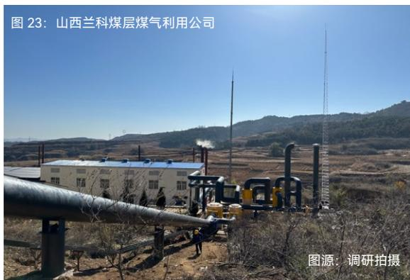
案例项目位于山西省晋城市高平市寺庄镇伯方村，由山西兰科煤层气利用科技有限公司（以下简称“山西兰科煤层气”）与山西兰花科技创业股份有限公司伯方煤矿分公司（以下简称“伯方煤矿”）合作，在伯方煤矿赵家山风井场地建设低浓度瓦斯燃烧供热系统。瓦斯利用的浓度范围在 6% 以上。项目一方面可以减少
